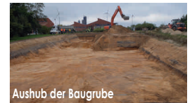
Aushub der Baugrube
