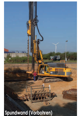
Spundwand (Vorbohren)
